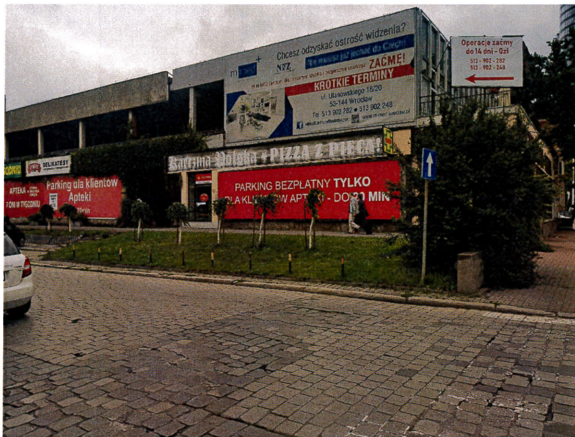
Zdjęcie nr 7 - widok na banery od ulicy, na tle budynku
